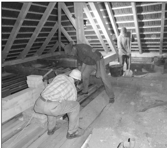
Die Dämmung bildet eine mineralisch gebundene Ausgleichschüttung mit einer Stärke von durchschnittlich 25 cm.
