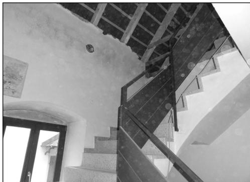
Durch verschiedene Niveaus und Deckenkonstruktionen gestaltet sich die Dämmung der obersten Geschoßdecke schwierig. Die Holztramdecken wurden nach den Vorschriften des Bundesdenkmalamtes gesichert.
